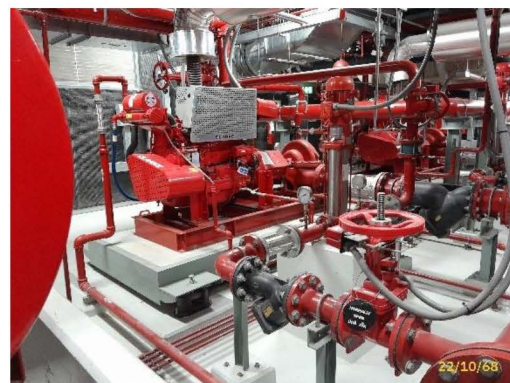
เครื่องสูบน้ำดับเพลิง High Zone (ซ้าย) และ Low Zone (ขวา)
