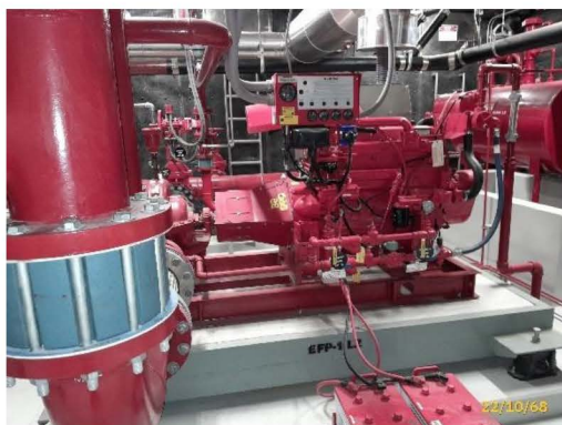
เครื่องสูบน้ำดับเพลิง High Zone (ซ้าย) และ Low Zone (ขวา)
