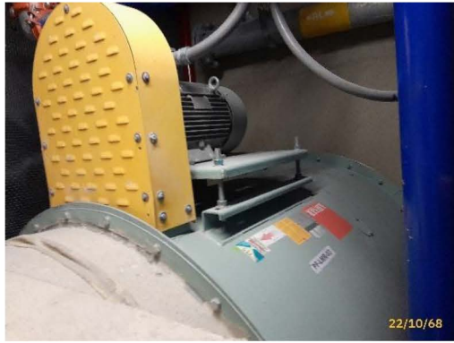
ระบบอัดอากาศบันไดหนีไฟ
