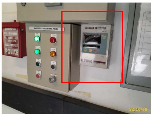
แผงควบคุมอุปกรณ์ตรวจสอบก๊าซ
