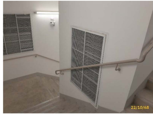
ระบบอัดอากาศบันไดหนีไฟ
