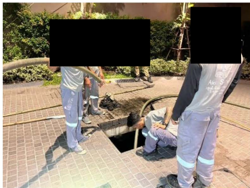
การสูบน้ำตะกอนส่วนเกินและไขมัน
